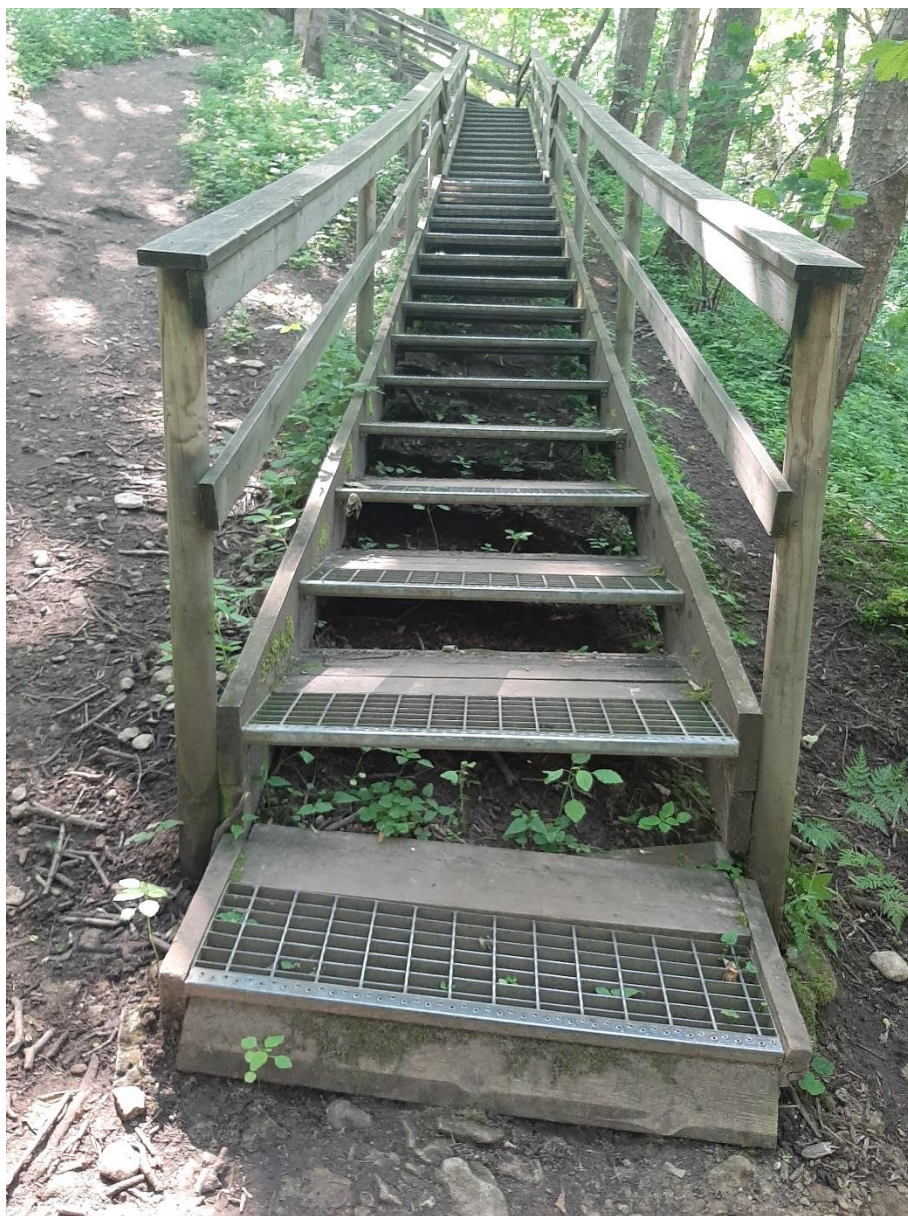
Foto 11. Amortiseerunud kagutrepi puitosa
